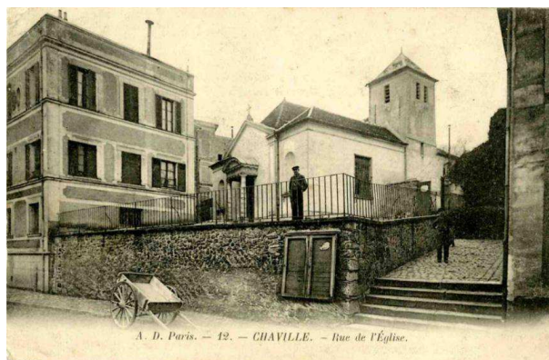
L'église Notre-Dame démolie en 1966
